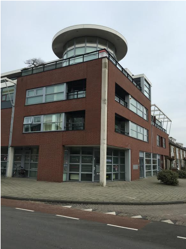
Voorkant en ingang gebouw
